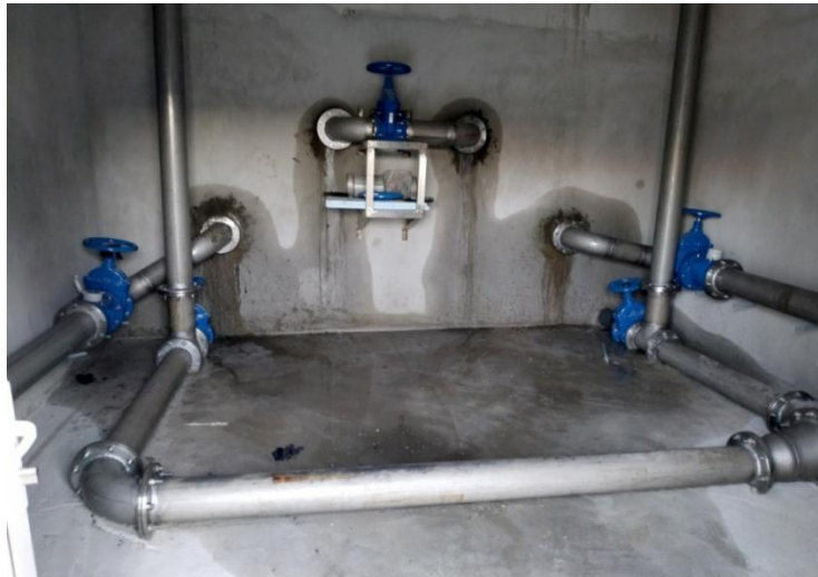
Εικόνα 1: ενδεικτική διάταξη σωλήνων εισόδου – εξόδου νερού εντός του οικίσκου της δεξαμενής
